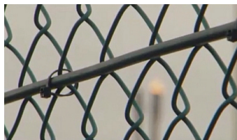
振動を光ファイバーケーブルが検知
